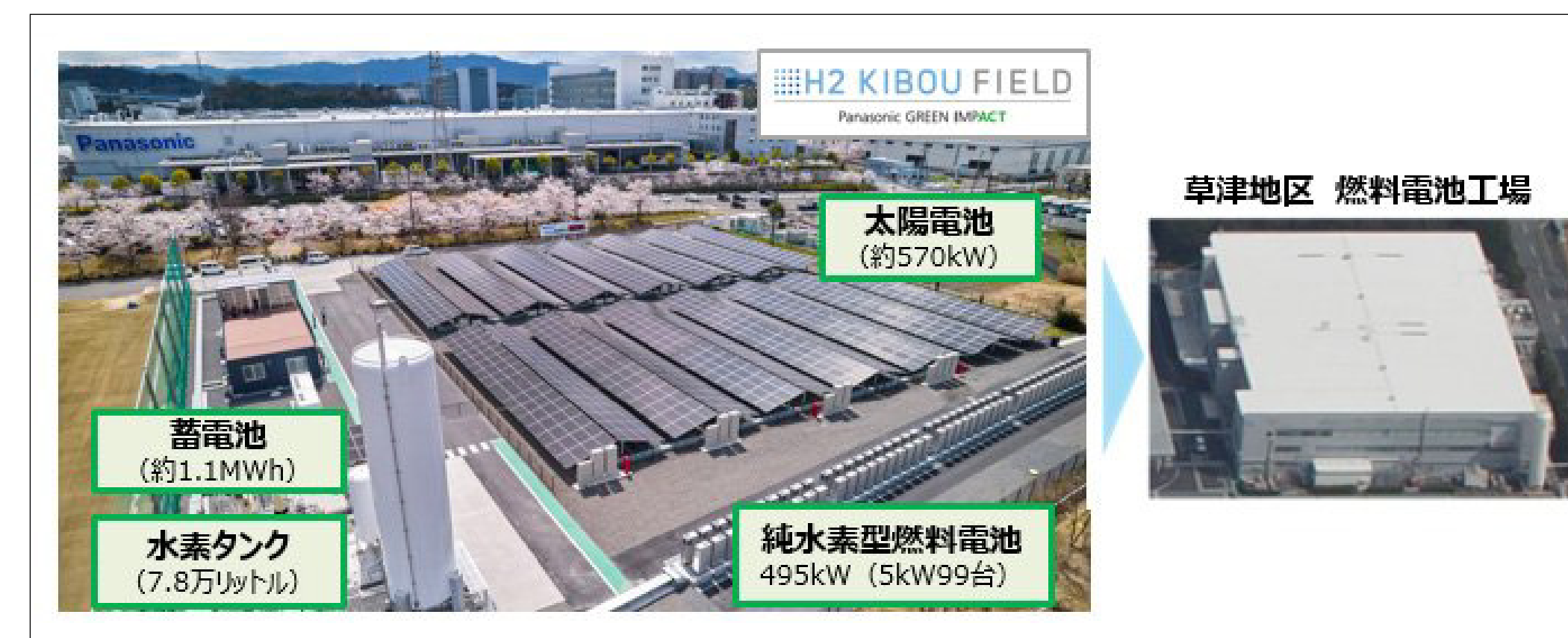
純水素型燃料電池と太陽電池を組み合わせた自家発電により、事業活動で消費するエネルギーを100%再生可能エネルギーで賄う「RE100ソリューション」を稼働します。
