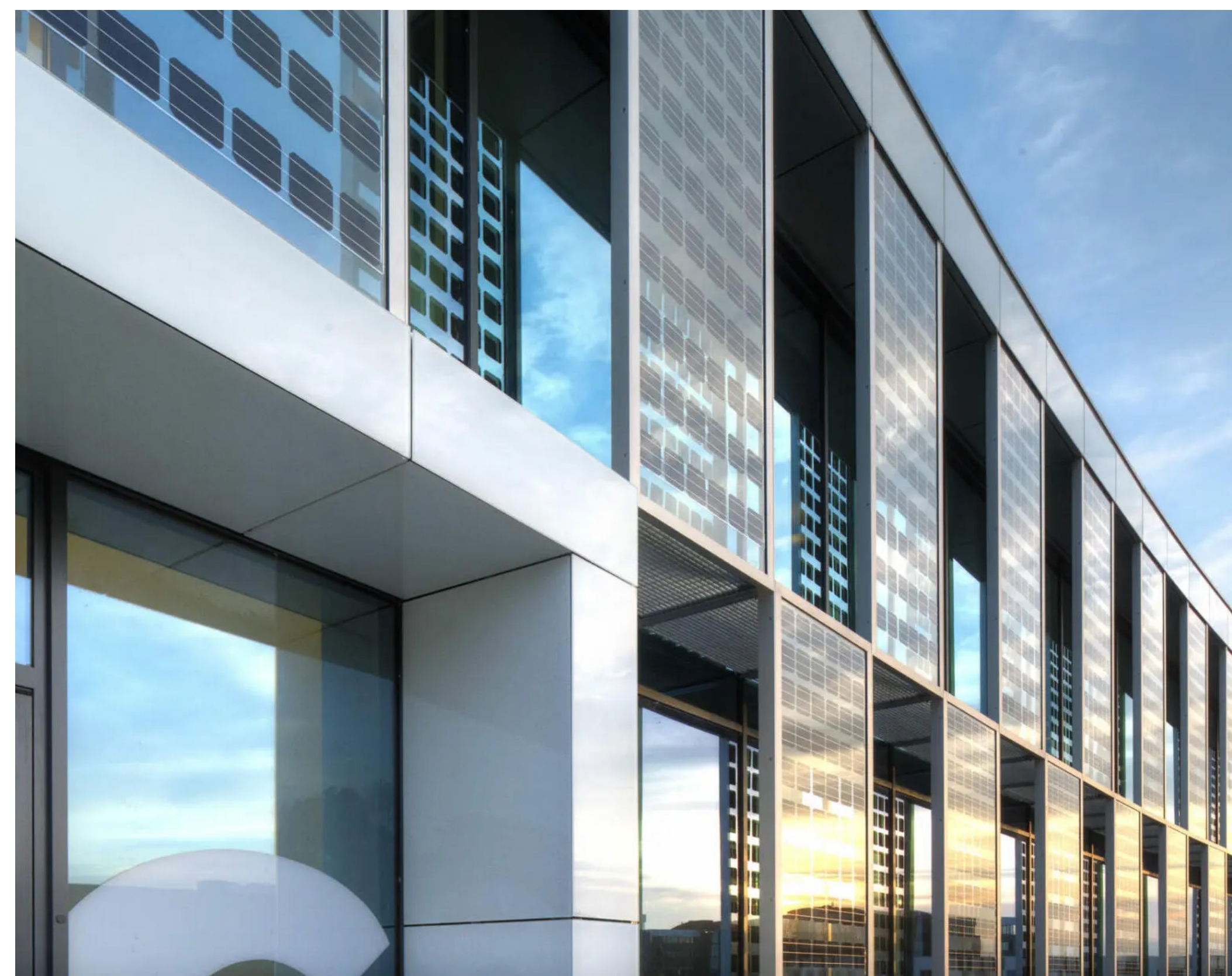
SunEwat Visionは、セル配列、モジュール形状、使用するガラスの種類などをフル・カスタマイズすることができ、建築ガラスの機能を生かしながら創エネすることが可能になります。
