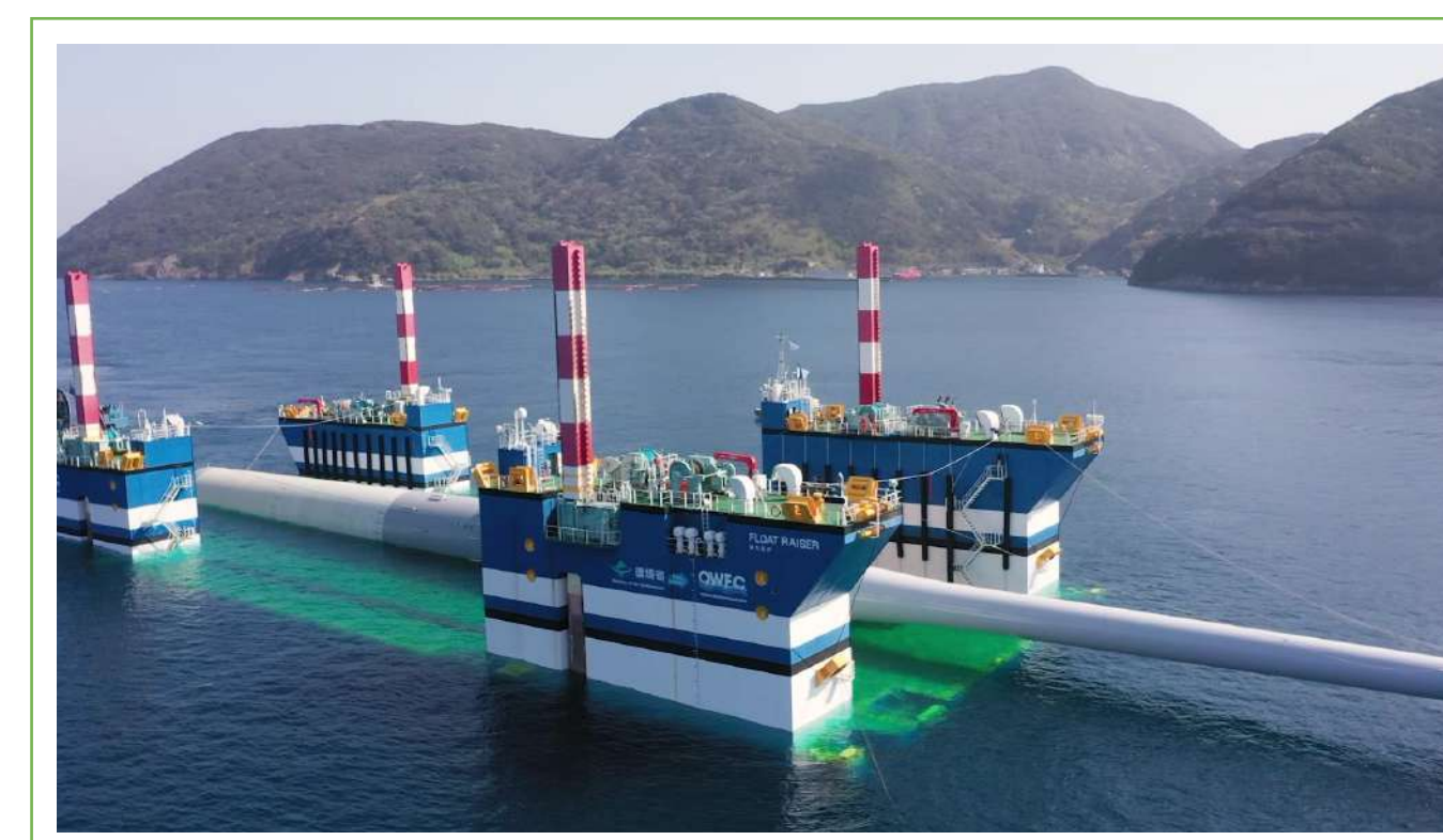
浮体の半潜水船からの引き出し Tugging off the floater from the vessel
