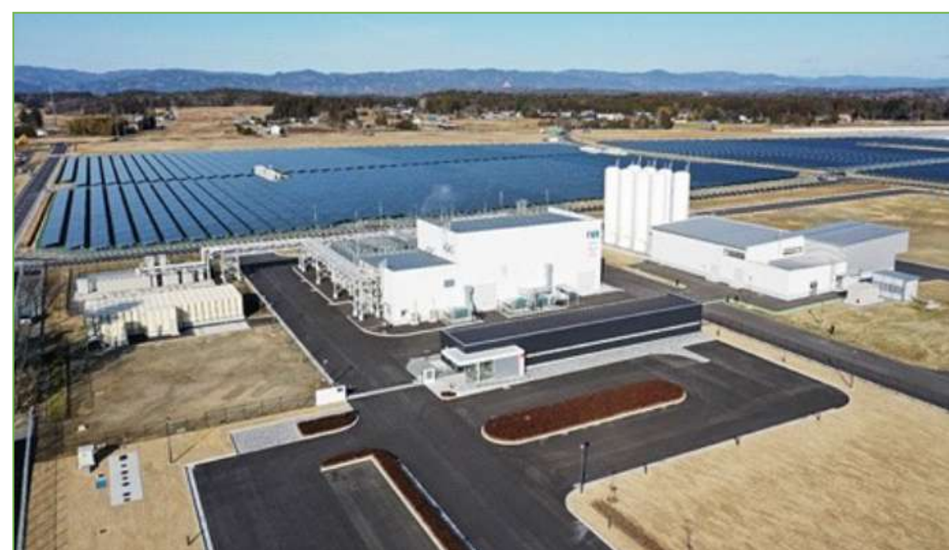
図1 福島県浪江町の「福島水素エネルギー研究フィールド」 Fig.1 FH2R : Fukushima Hydrogen Energy Research Field
