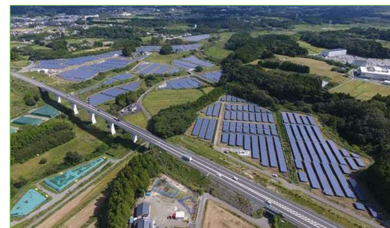
図3 大熊エネルギー・メガソーラー発電所（出所：NTT ファシリティーズ） Fig.3 Okuma Energy Mega Solar Power Plant
